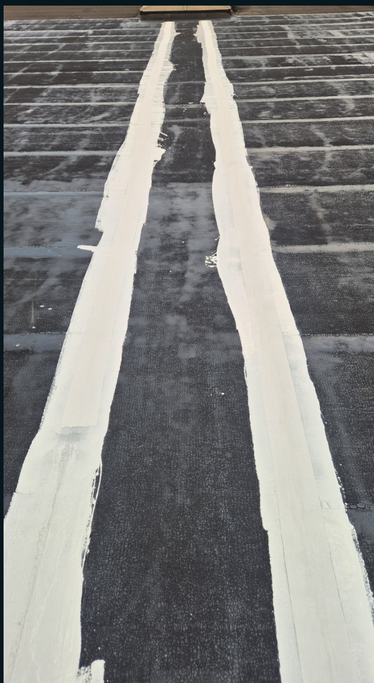
PLAATSELIJKE GEOTEXTIELVERSTERKING
